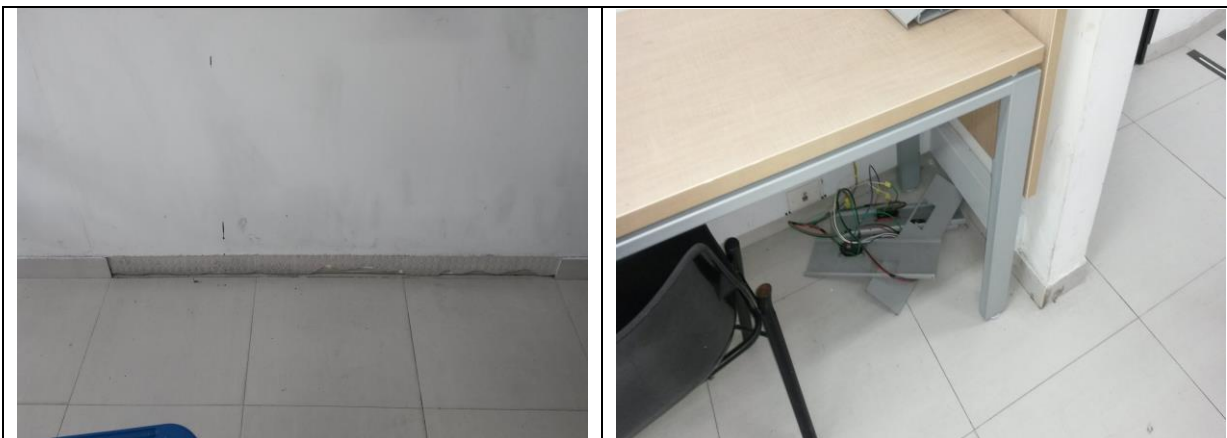
Izq. Desprendimiento de Guarda escobas adosadas a los muros en drywall. Der. Desprendimiento de canaletas que dejan al descubierto las conexiones eléctricas sin señalización alguna.
