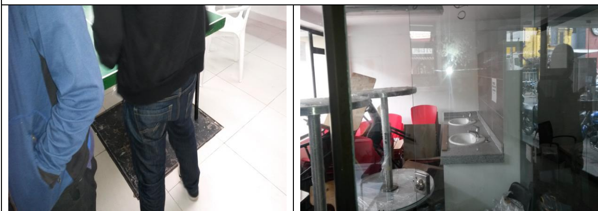
Izq. Tapa del tanque subterráneo en el salón de juegos del primer nivel. Der. Estado actual del consultorio médico y de atención a urgencias, el cual sirve de depósito de materiales de oficina.
